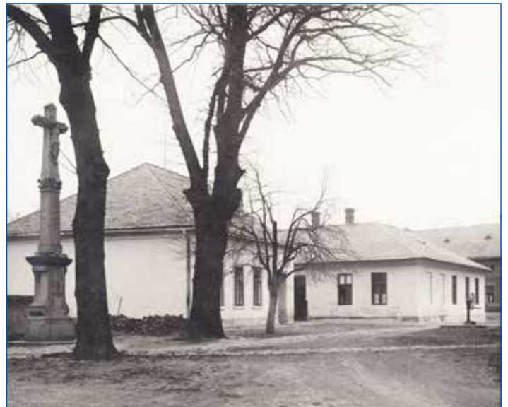
Stará škola – škola po opravě v r. 1906 1. budova (u kříže) – v ní byla první třída a na chodbě byla obecní knihovna přemístěna sem z hospody č. 9
