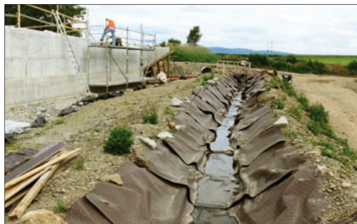
Provizorní koryto Rumzy
