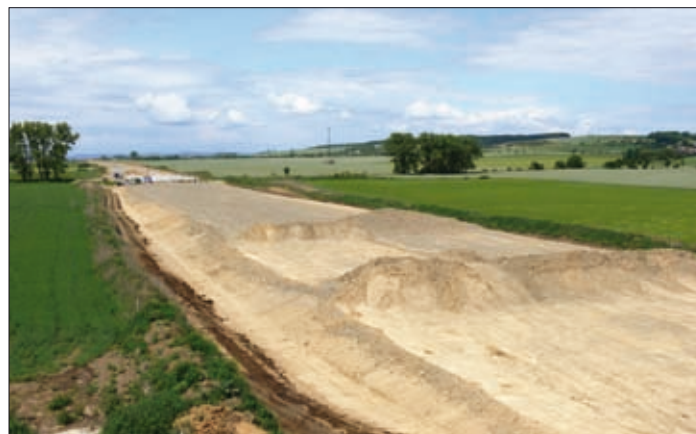
Pohled z náspu budoucího mostu směrem na Říkovice
